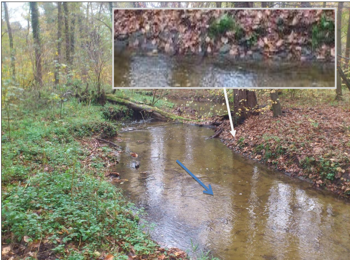
Abbildung 13: Gewässerabschnitt des Apfelbachs im Wald. Rechtes Ufer (Prallhang) entfesselt mit wertvollen Totholzstrukturen. Gleithang linkes Ufer mit Wasserbausteinen befestigt.
